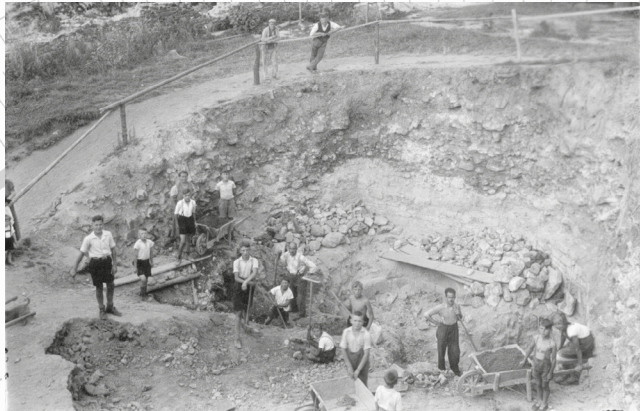
Ausgrabungsarbeiten am Brunnenhaus, 1935
